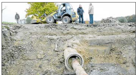
Ein bestehendes Becken im Bereich der Von-Büren-Allee und der Albert-Einstein-Straße wird mit neuer Regeltechnik aufgerüstet.
