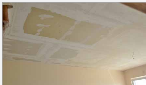
Neue Decke aus Gipskarton
